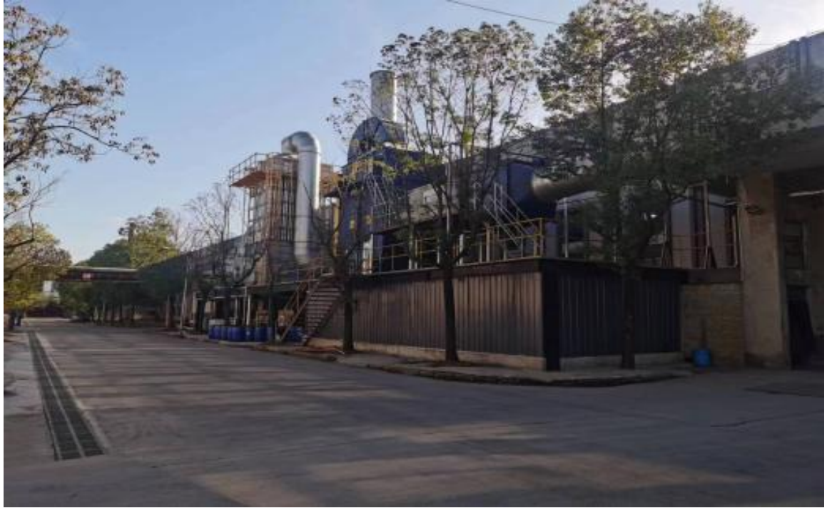
定型机废气处理装置
