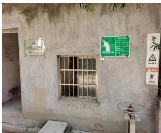
智能化雨水排放监控系统
