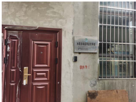
废水在线监测系统
